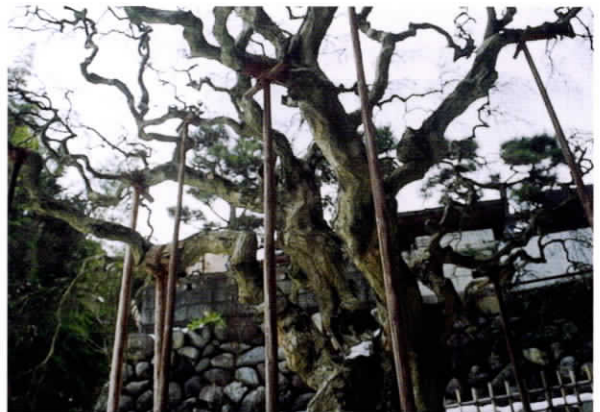
支柱の状況と南側の家（平成13年2月）
